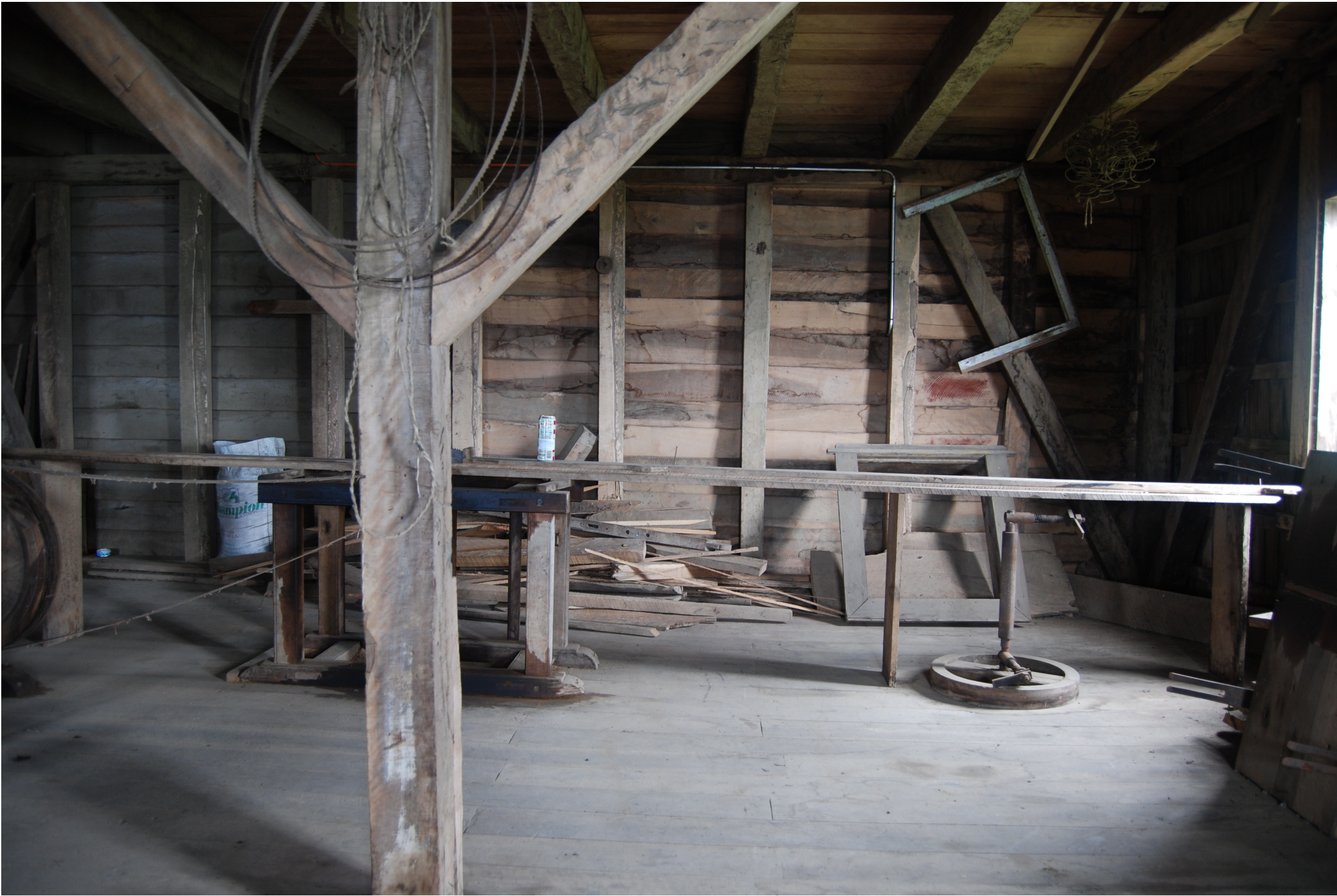
FOTO ESTRUCTURA PERIMETRAL
