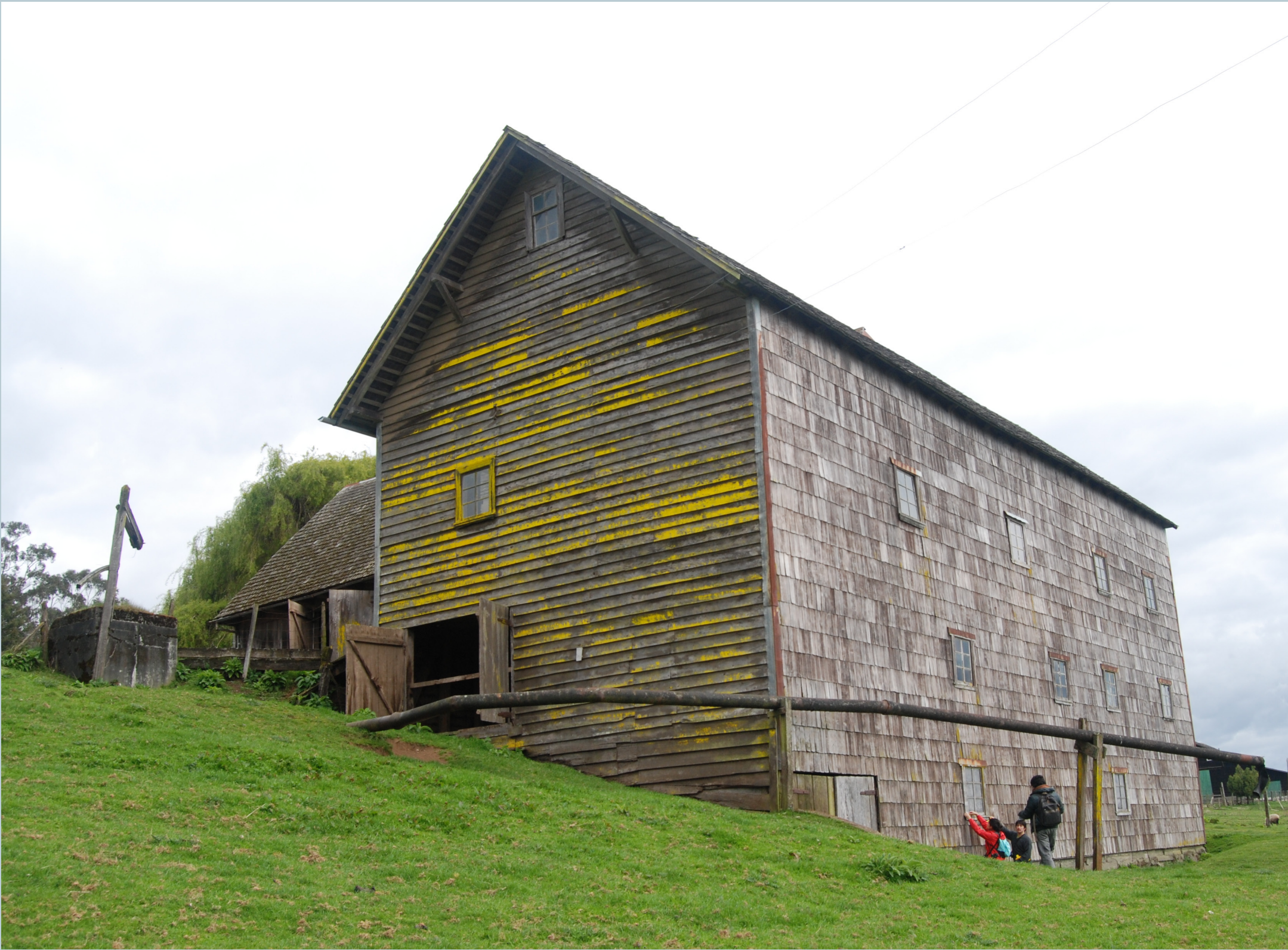
FOTO REVESTIMIENTO EXTERIOR
