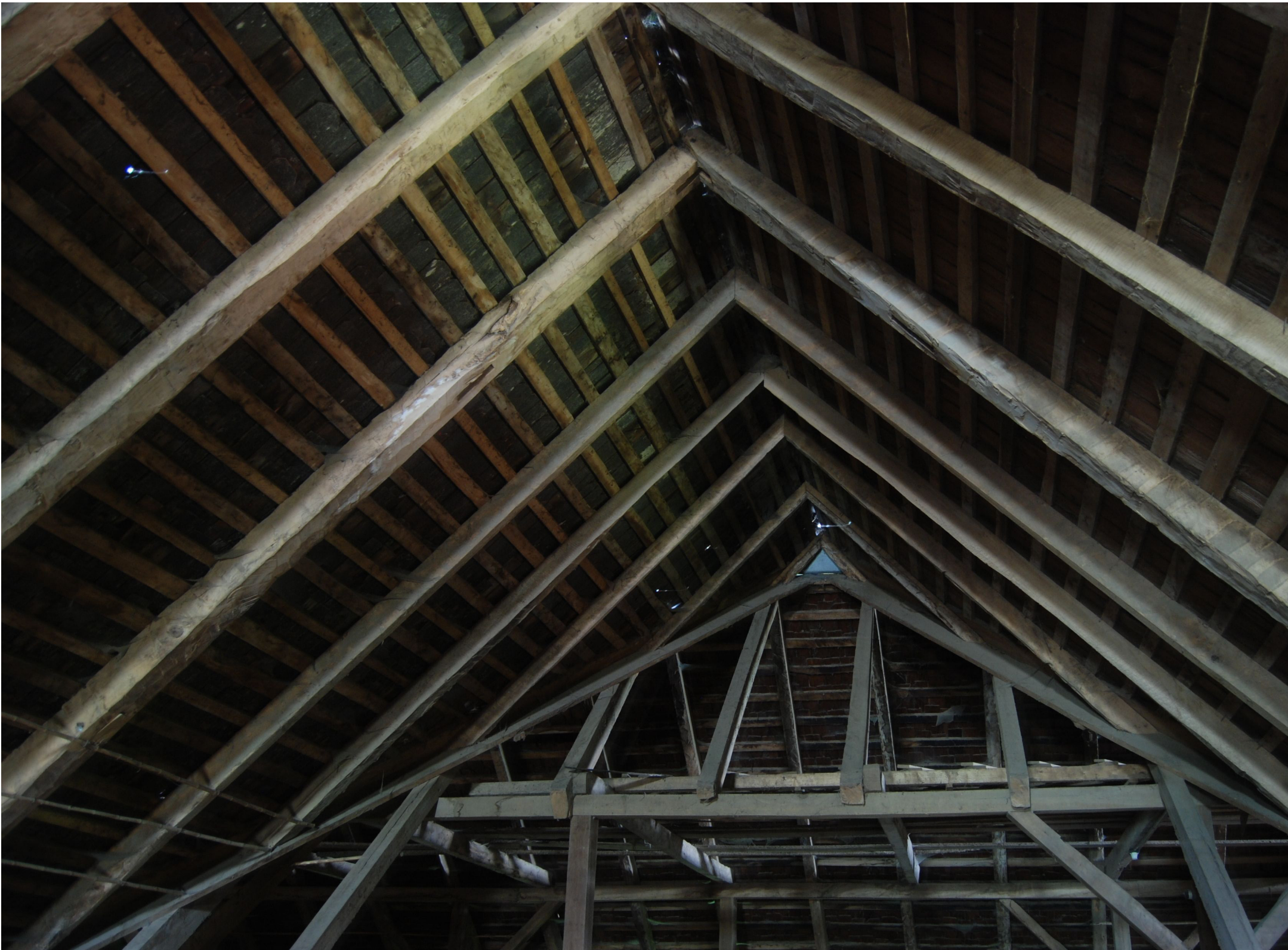
FOTO ESTRUCTURA TECHUMBRE
