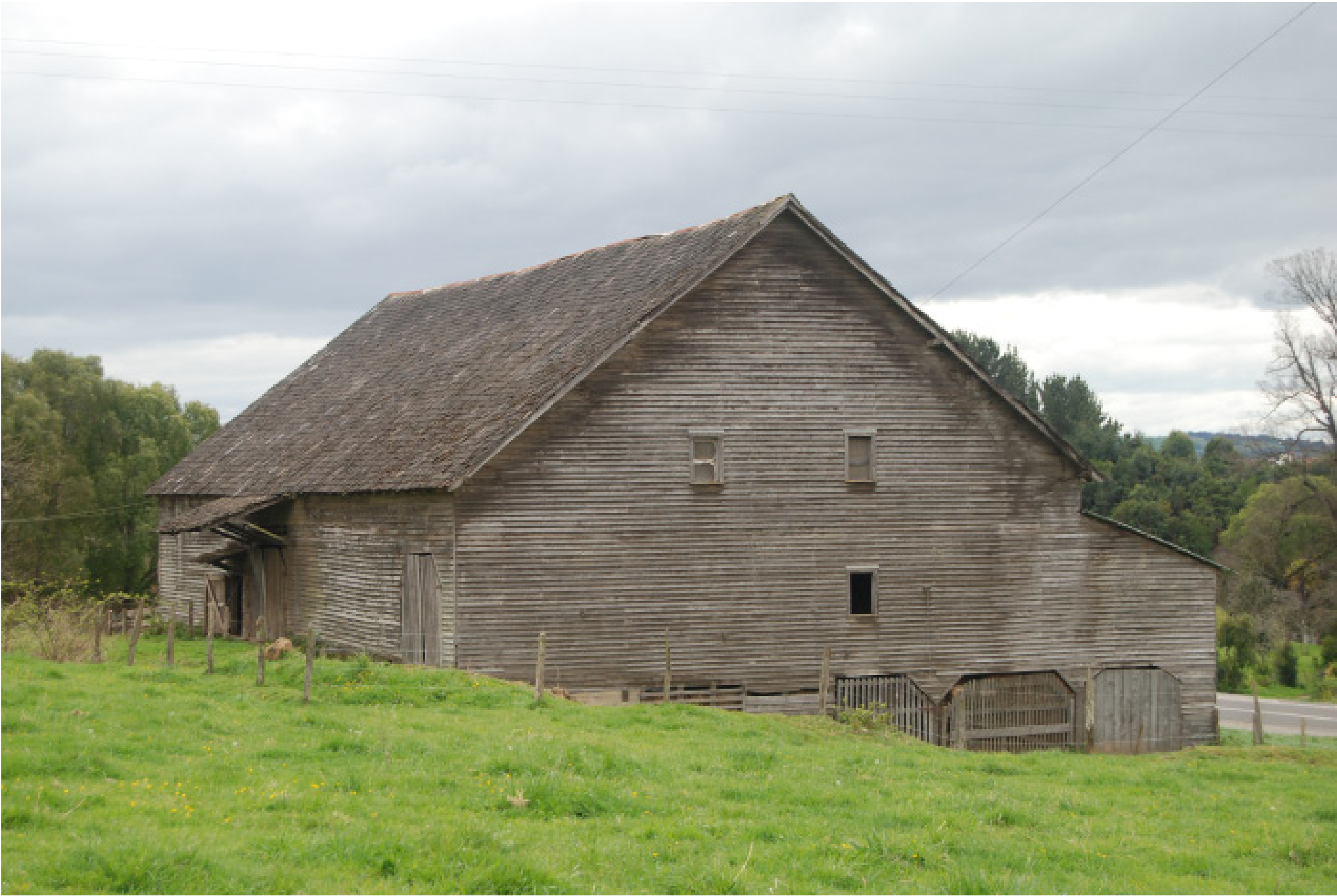
FOTO REVESTIMIENTO EXTERIOR
