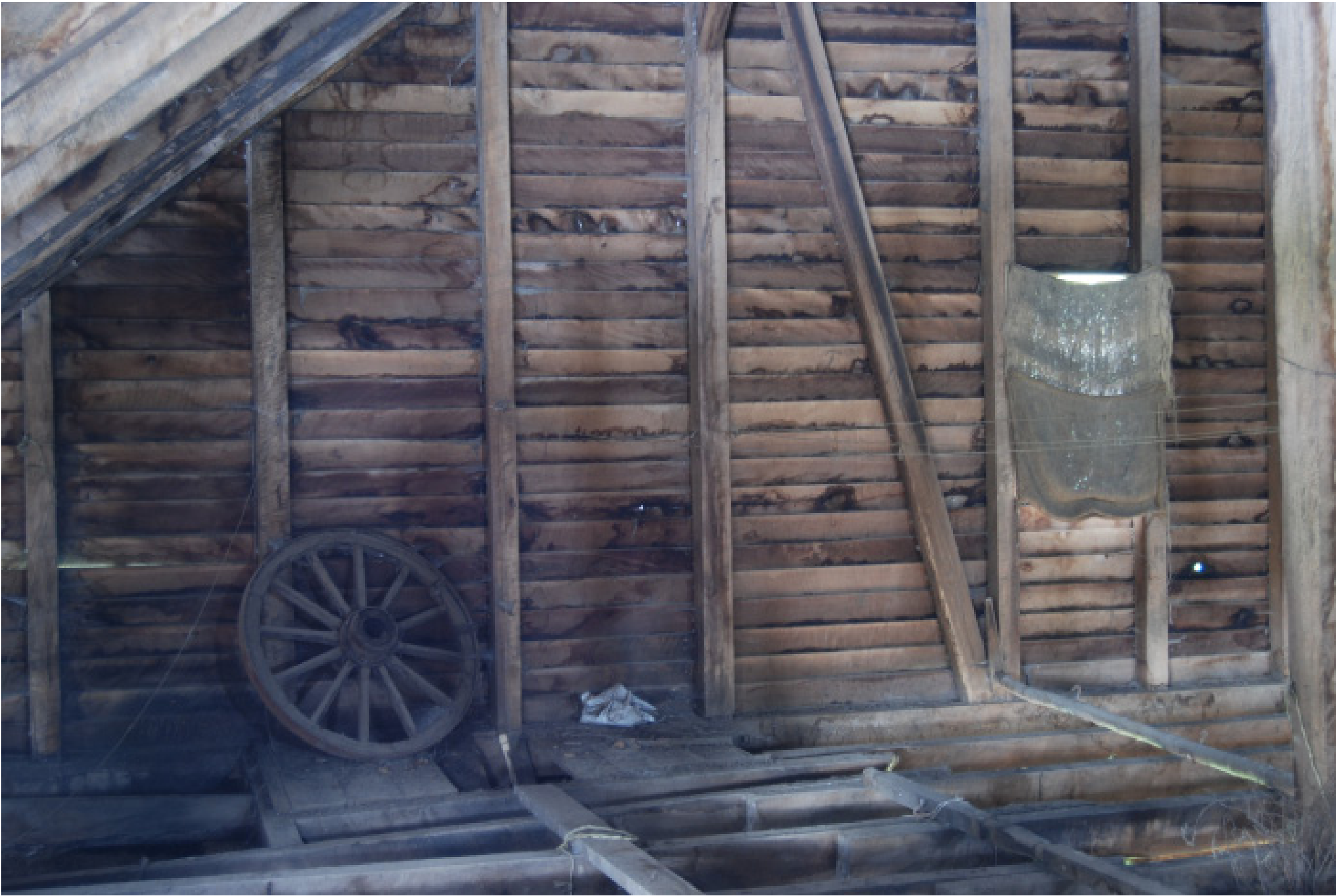
FOTO ESTRUCTURA PERIMETRAL
