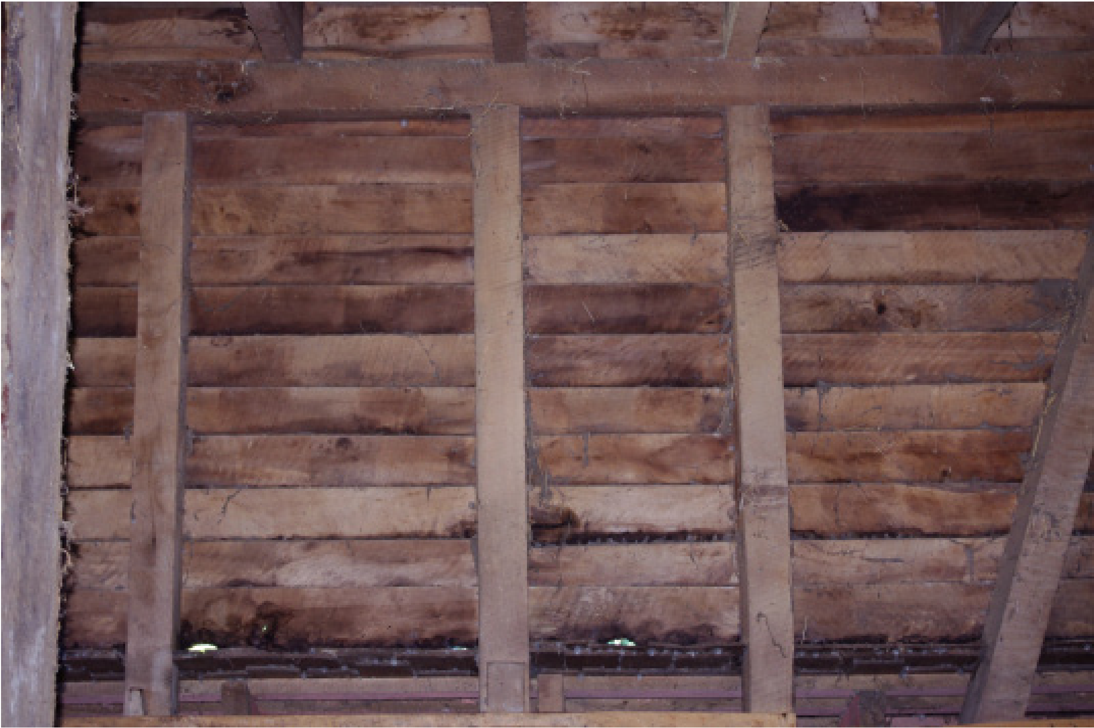
FOTO ESTRUCTURA PERIMETRAL
