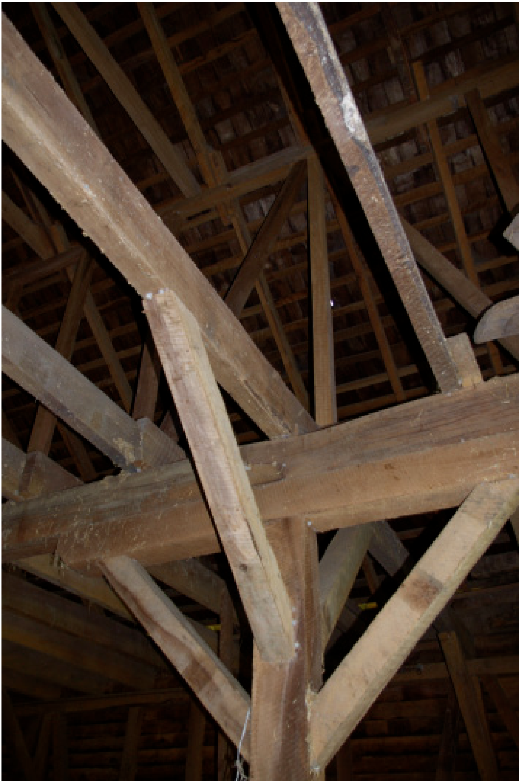
FOTO ESTRUCTURA TECHUMBRE
