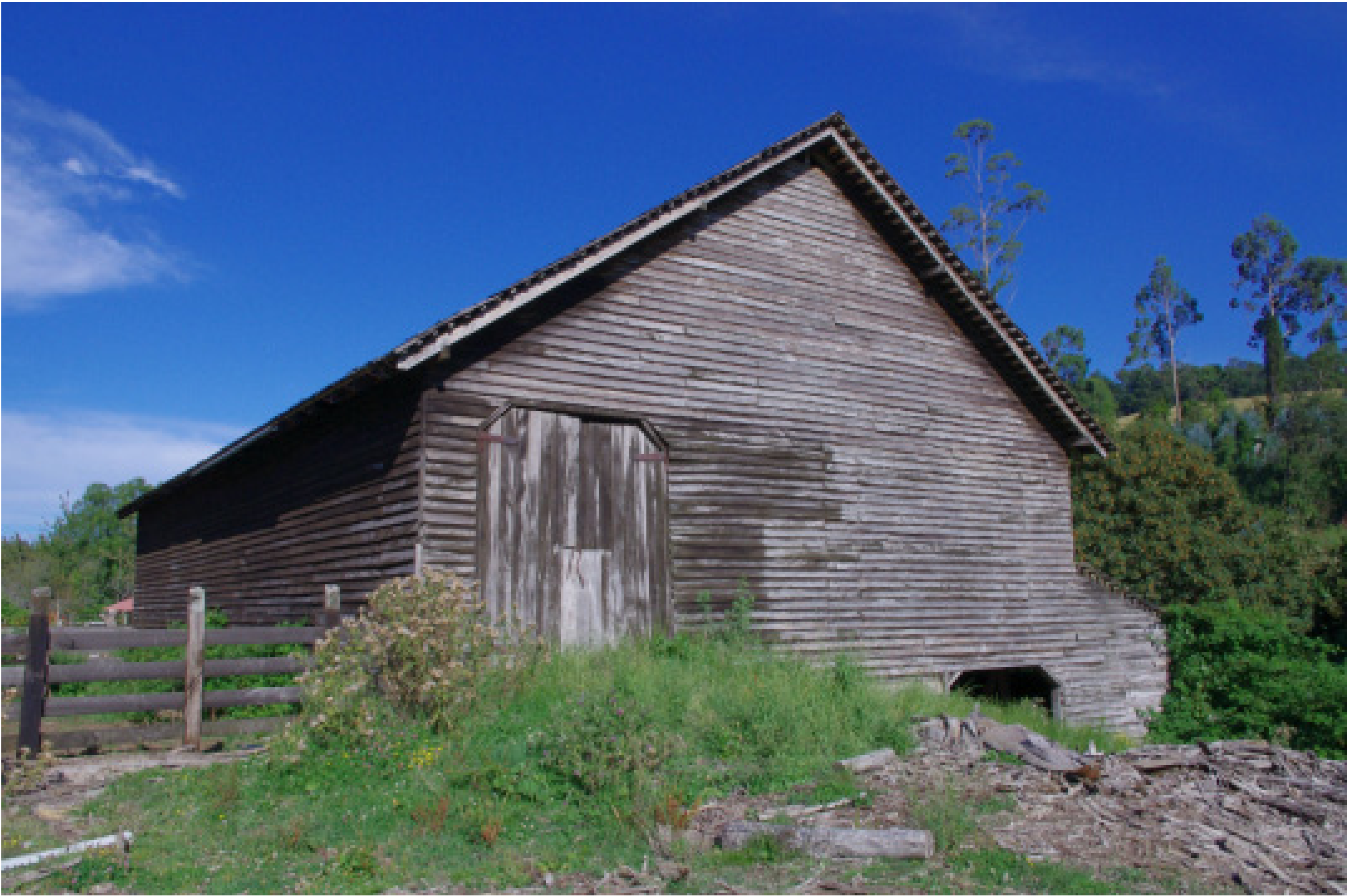
FOTO REVESTIMIENTO EXTERIOR
