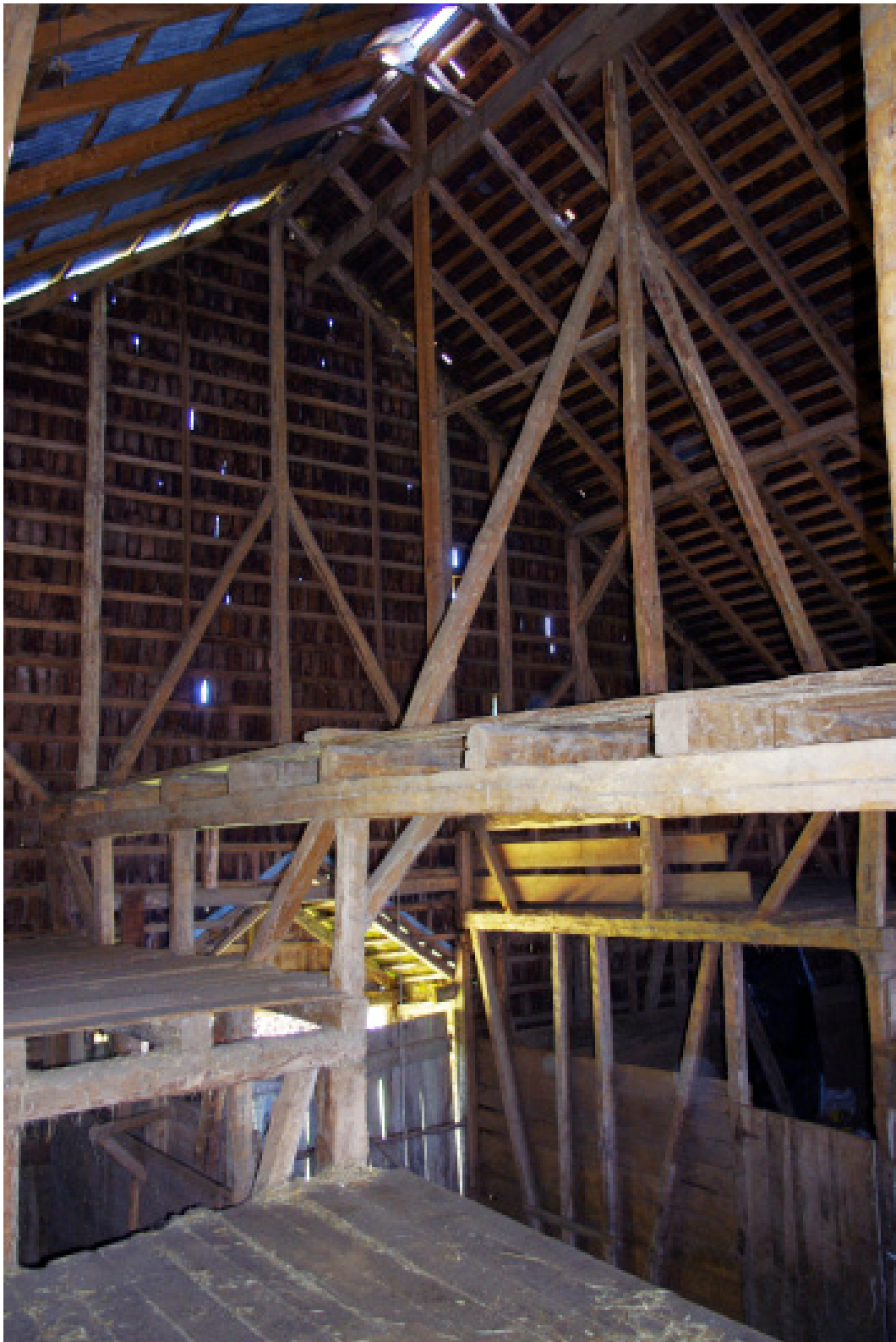
FOTO ESTRUCTURA TECHUMBRE
