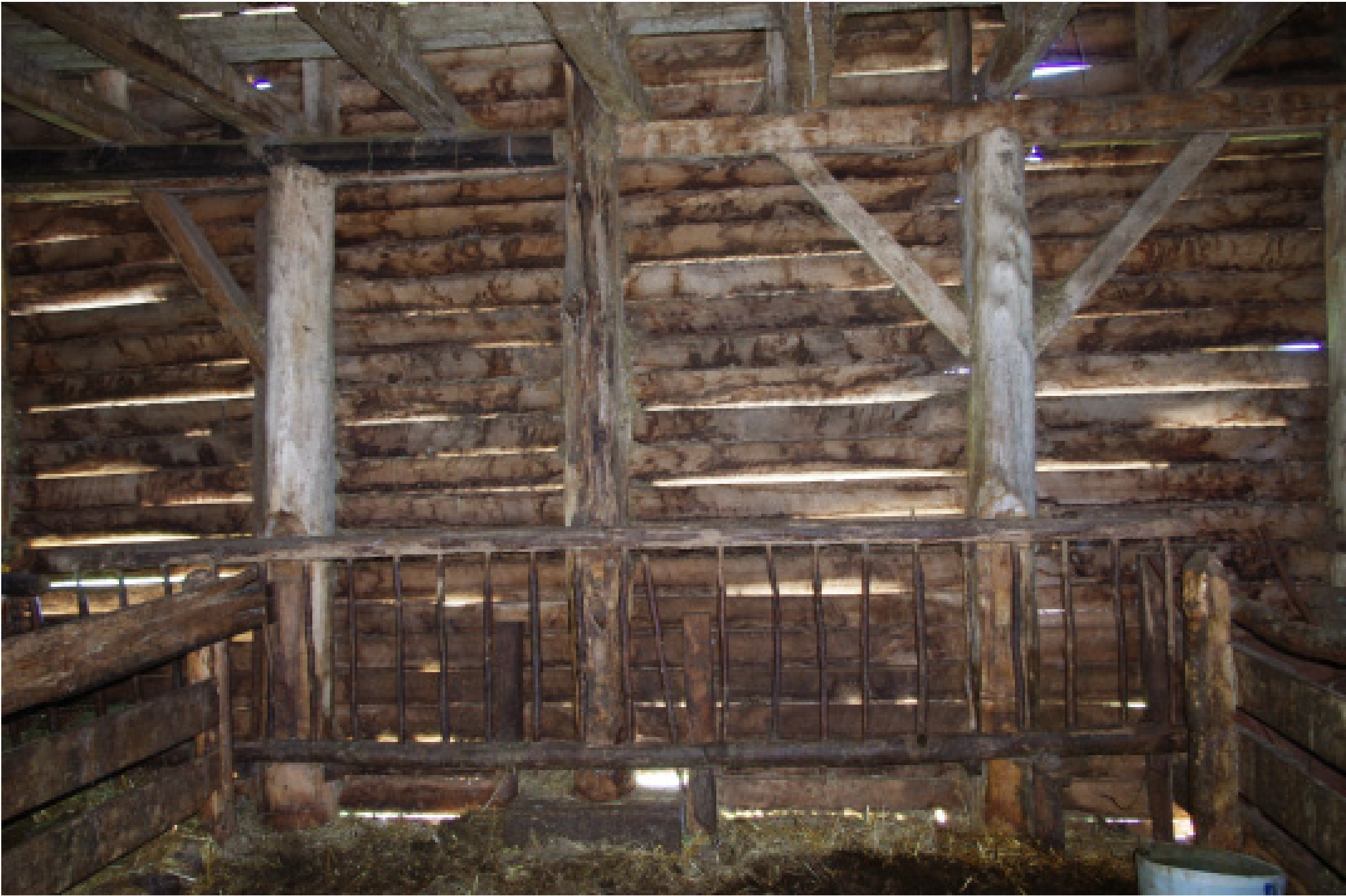
FOTO ESTRUCTURA PERIMETRAL
