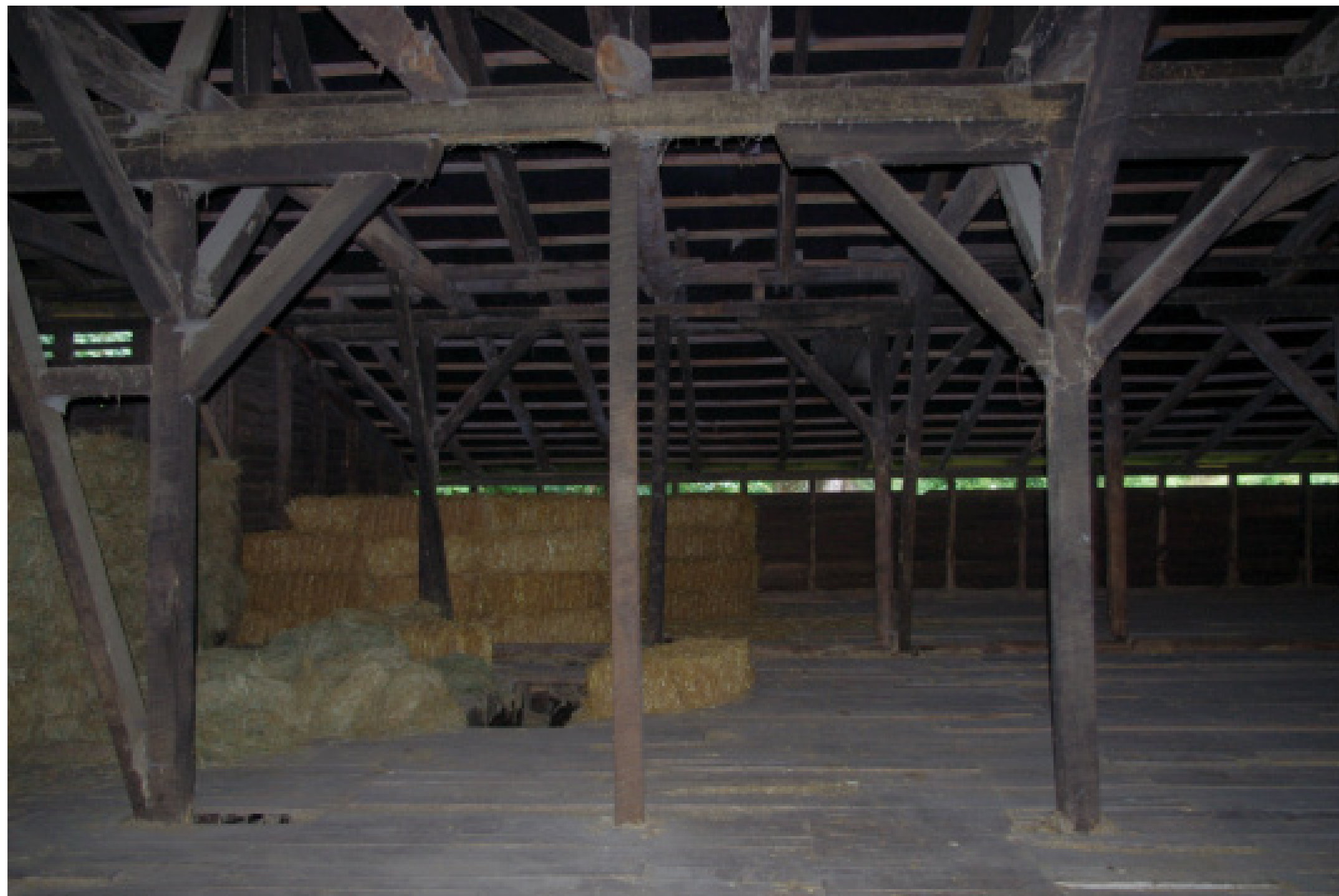
FOTO ESTRUCTURA PERIMETRAL
